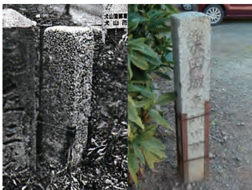
図4 石碑の補強の例 左…黒平山秋葉道 右…樂田城裏門旧跡
